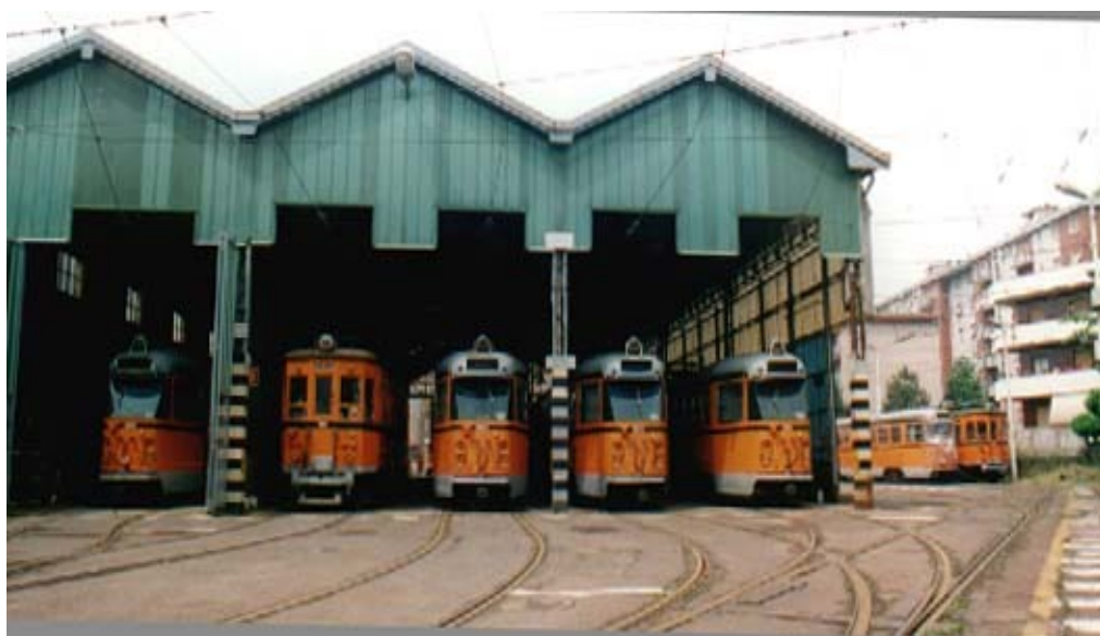
Deposito di Varedo
