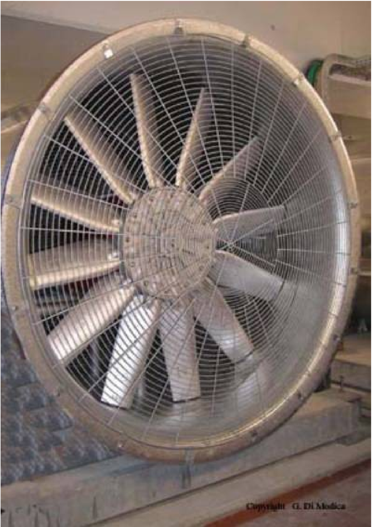
uno degli imponenti ventilatori per l'aerazione della stazione
