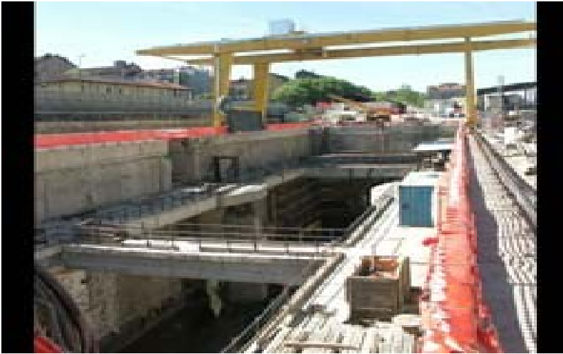
Il cantiere della metropolitana presso
