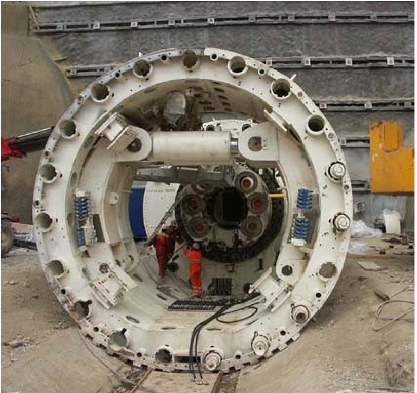
La talpa durante il montaggio (notare il diametro, confrontandolo con gli uomini che vi lavorano all'interno)
